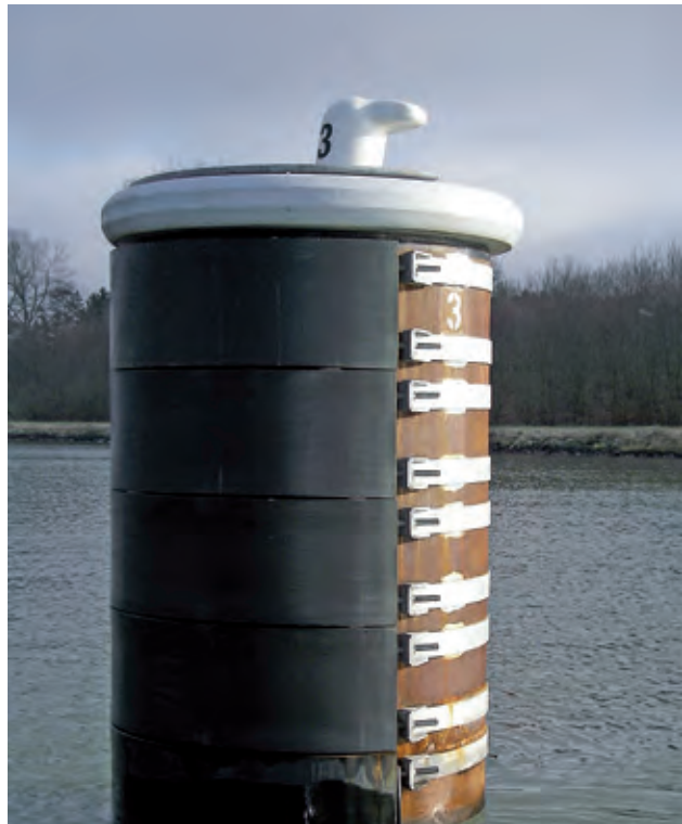
Standby pile | Kiel | Germany
