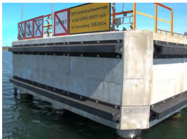
Ethanol Jetty | Stenungsund | Sweden
