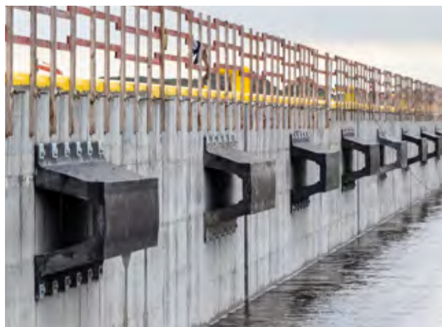
Boudewijnkanaal | Zeebrugge | Belgium
