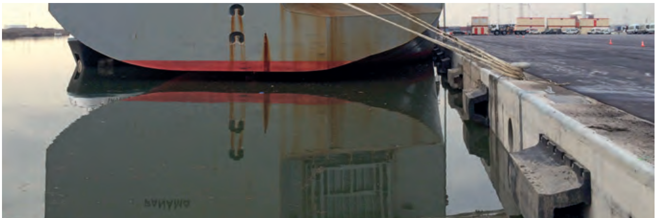
Toyotakaai | Zeebrugge | Belgium
